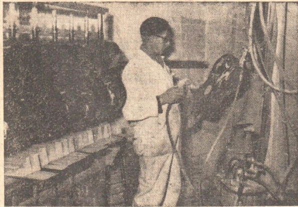
Het spuiten met lak is een nauwkeurig werkje en geeft het instrument zijn fraai uiterlijk.
